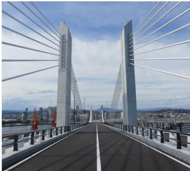
小名浜港東港地区臨港道路（小名浜マリブリッジ）
