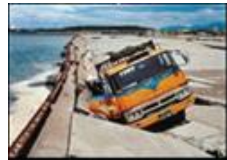
秋田港 大浜地区の陥没
